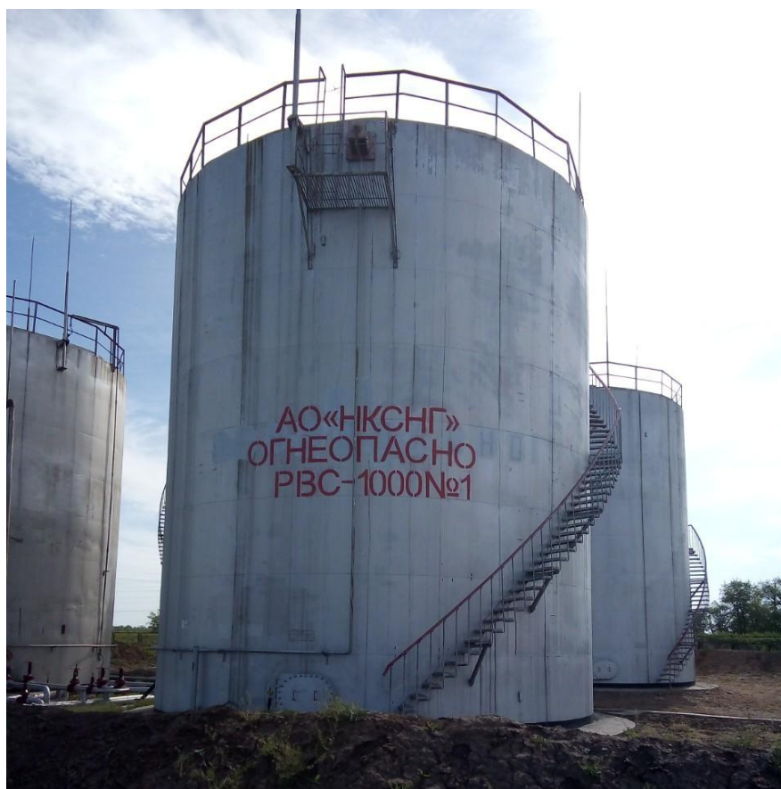
Рисунок 1 - Резервуар вертикальный стальной РВС-1000 №1
