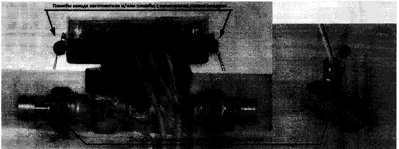
Рисунок 2 – Схема пломбировки теплосчетчика
