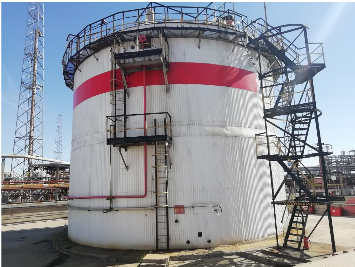
Рисунок 1 – Общий вид резервуара РВС-2000
