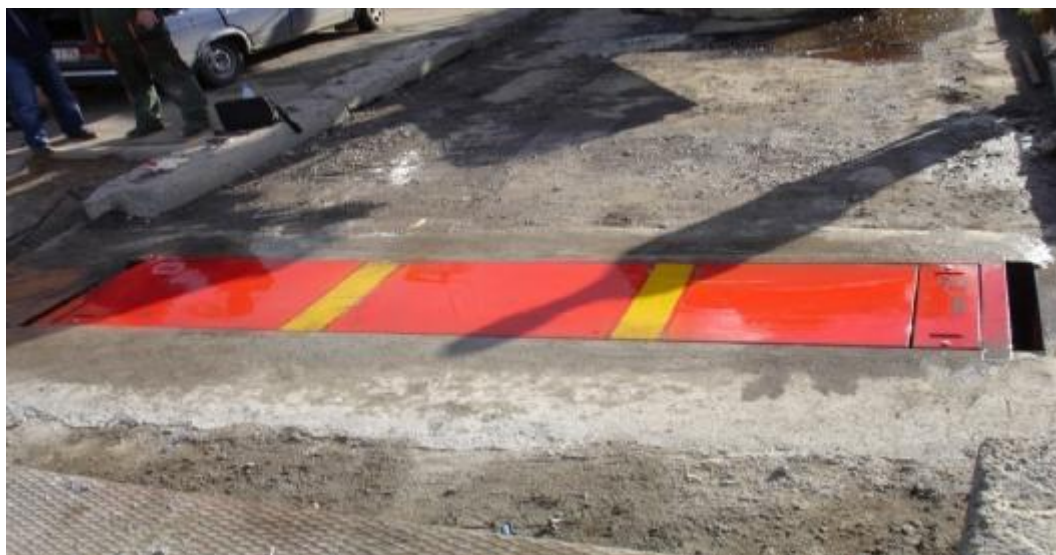
Рисунок 1 — Общий вид ГПУ для взвешивания ТС по частям в движении (пример)
