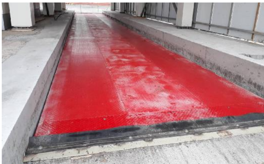
Рисунок 2 — Общий вид ГПУ для взвешивания ТС в движении, а также в режиме статического взвешивания (пример)
