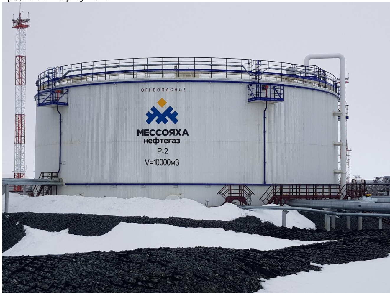
Рисунок 1 – Общий вид резервуара РВС-10000
