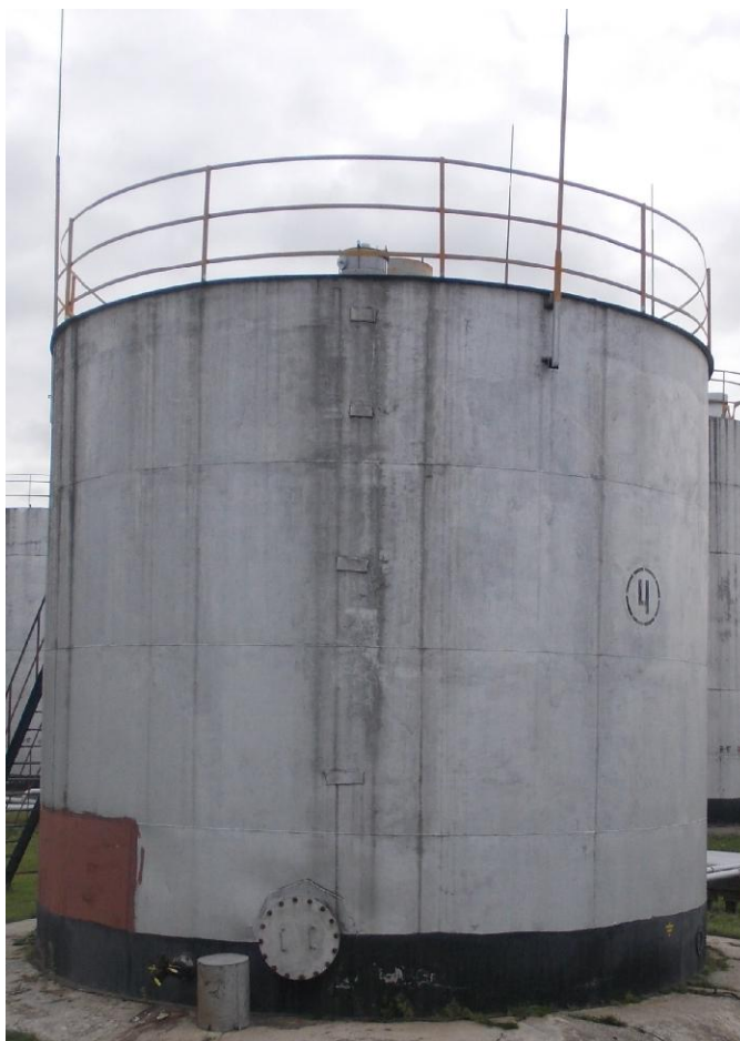
Рисунок 1 - Общий вид резервуара стального вертикального цилиндрического РВС-200
