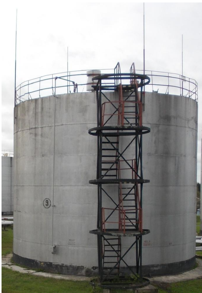
Рисунок 2 - Общий вид резервуара стального вертикального цилиндрического РВС-700
