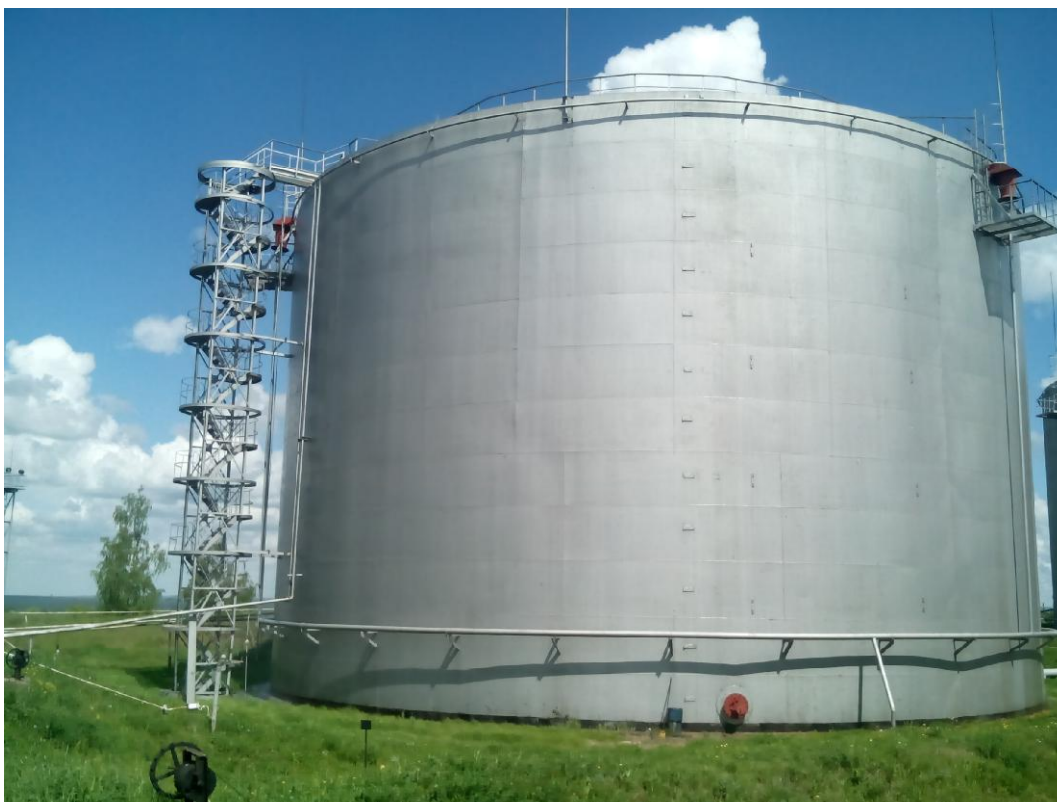
Рисунок 2 - Общий вид резервуаров вертикальных стальных цилиндрических РВС-10000
