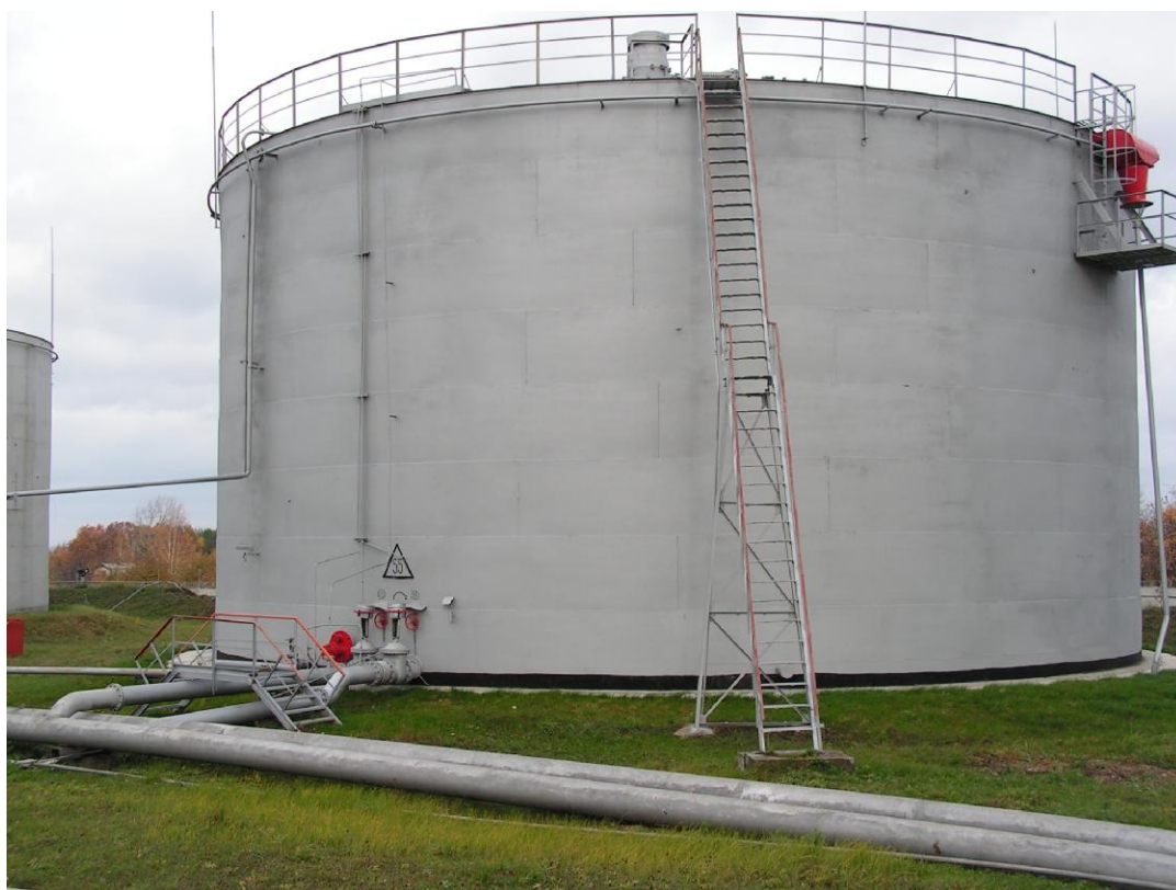
Рисунок 1 - Общий вид резервуаров вертикальных стальных цилиндрических РВС-5000
