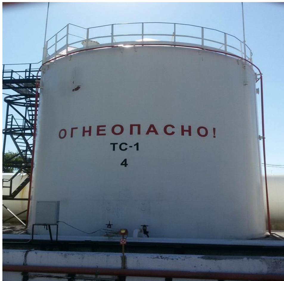
Рисунок 1 - Общий вид резервуаров стальных вертикальных цилиндрических РВС-400
