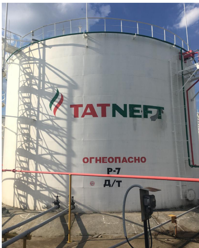
Рисунок 1 - Общий вид резервуара РВС-3000
