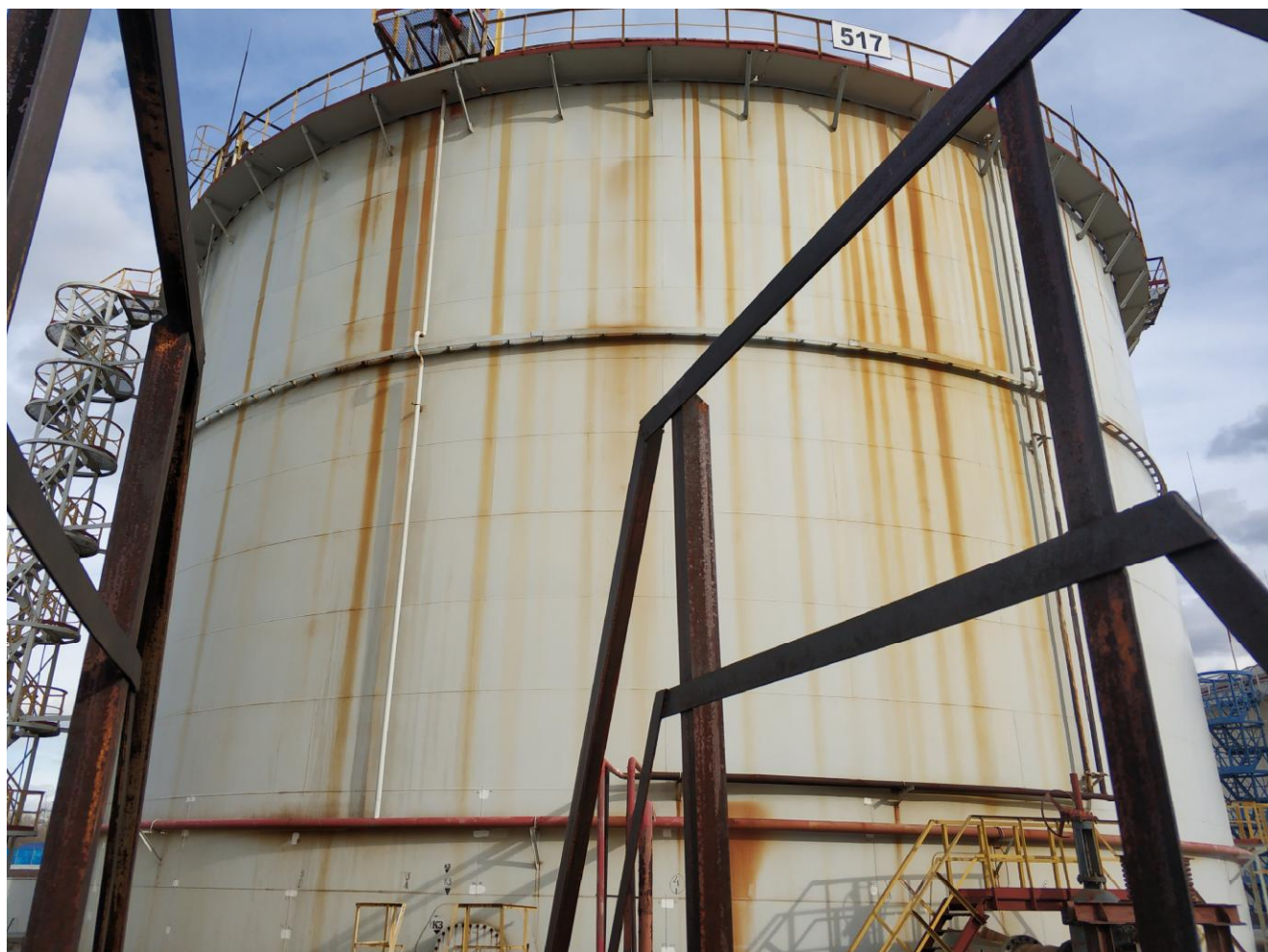
Рисунок 1 - Общий вид резервуара РВСПК-10000
