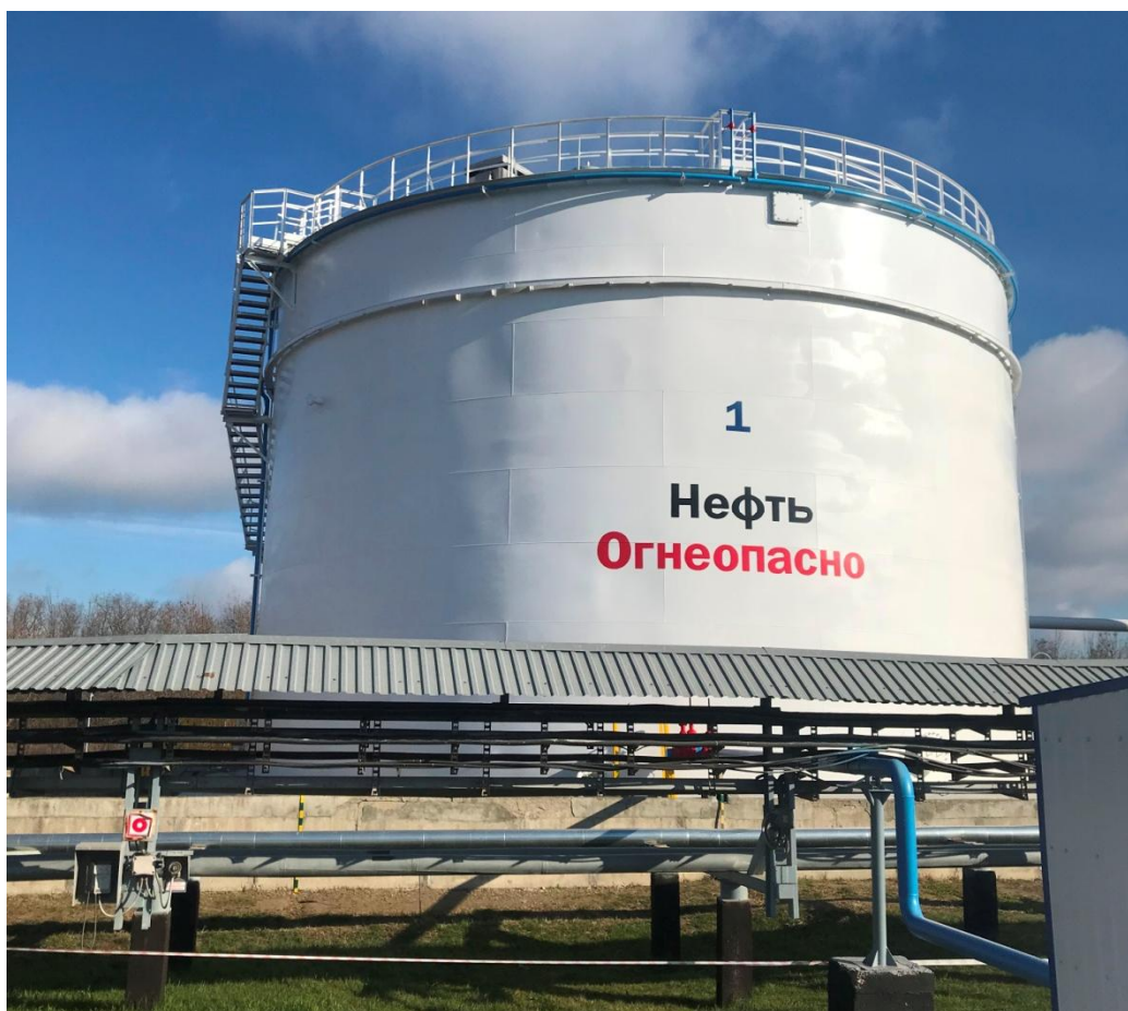
Рисунок 1 - Общий вид резервуара № 1
