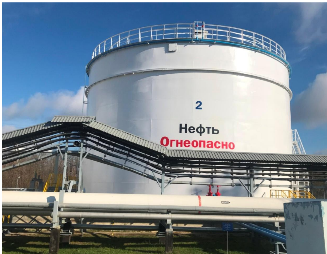
Рисунок 2 - Общий вид резервуара № 2
