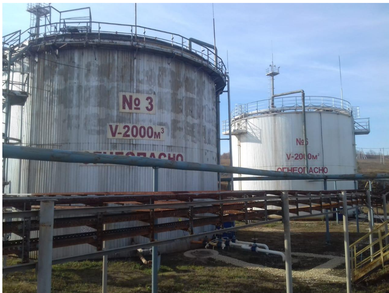
Рисунок 1 - Общий вид резервуаров РВС-2000
