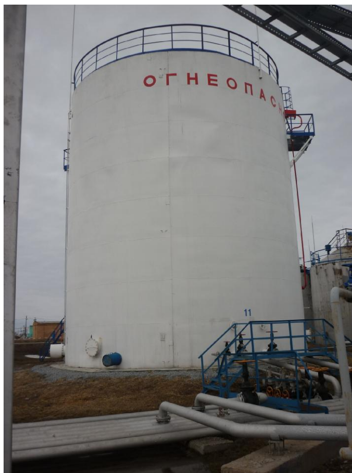
Рисунок 1 - Общий вид резервуара вертикального стального цилиндрического РВС-1000
