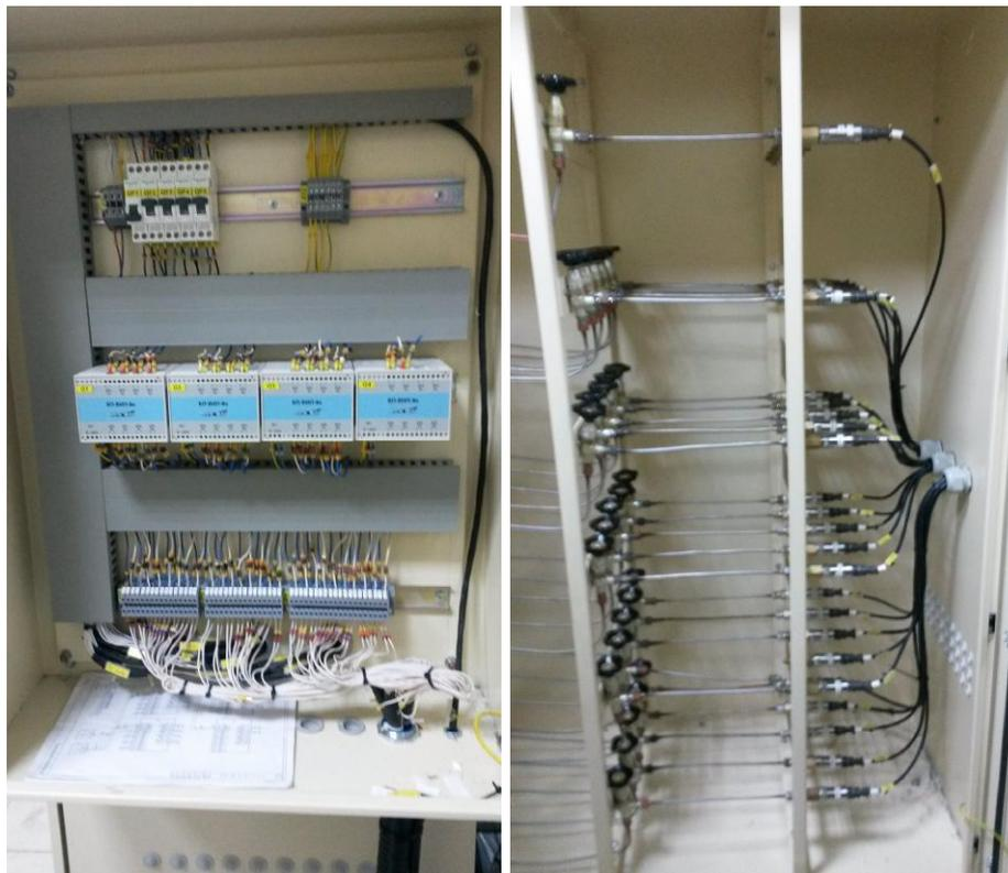
Рисунок 5 - Шкаф измерения давлений, расположенный в пультовой.
