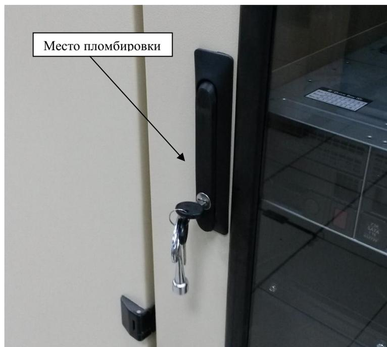
Рисунок 6 - Место пломбировки от несанкционированного доступа
