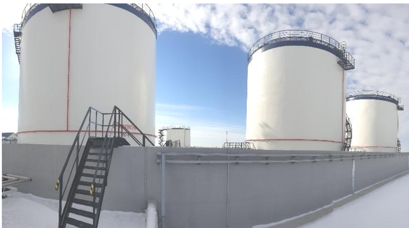
Рисунок 1 - Общий вид резервуаров
