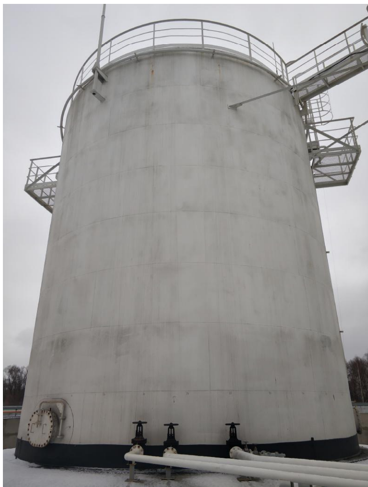
Рисунок 1 - Общий вид резервуара РВСП-1000
