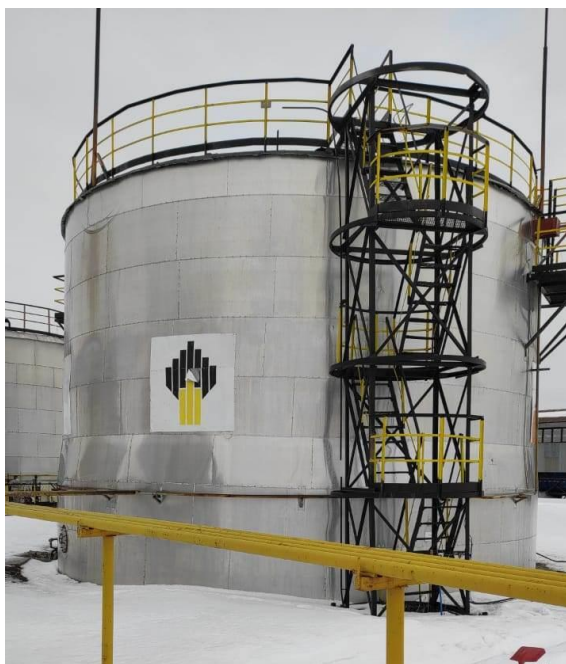
Рисунок 1 – Общий вид резервуаров
