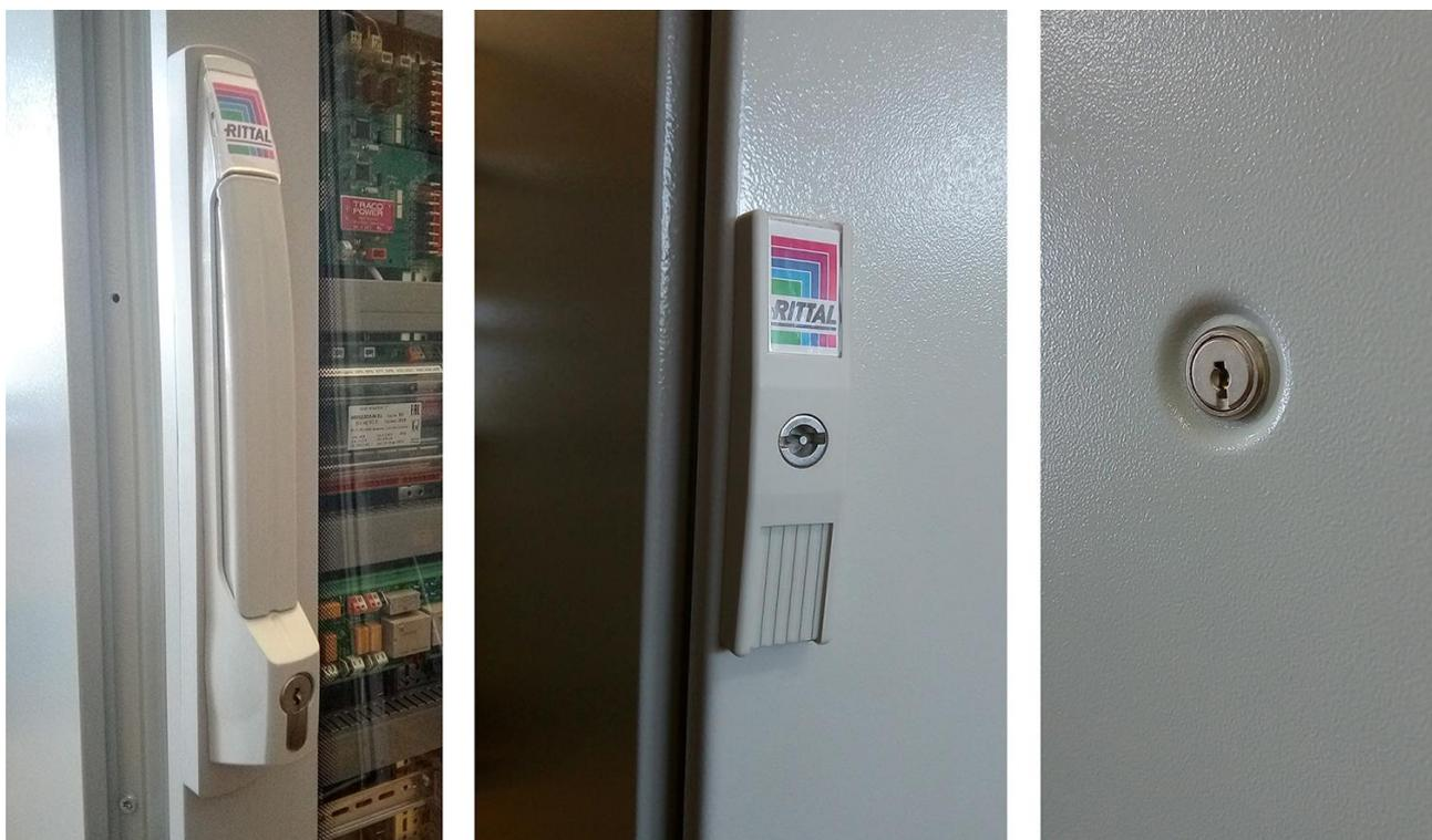
Рисунок 2 – Внешний вид замков дверей и боковых стенок стойки СУРП-М
