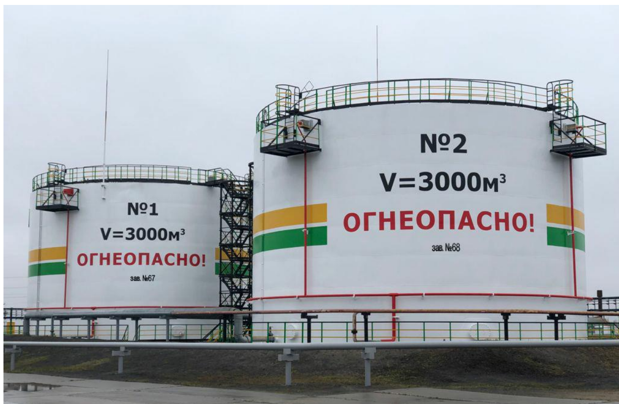
Рисунок 1 – Общий вид резервуаров стальных вертикальных цилиндрических РВС-3000
