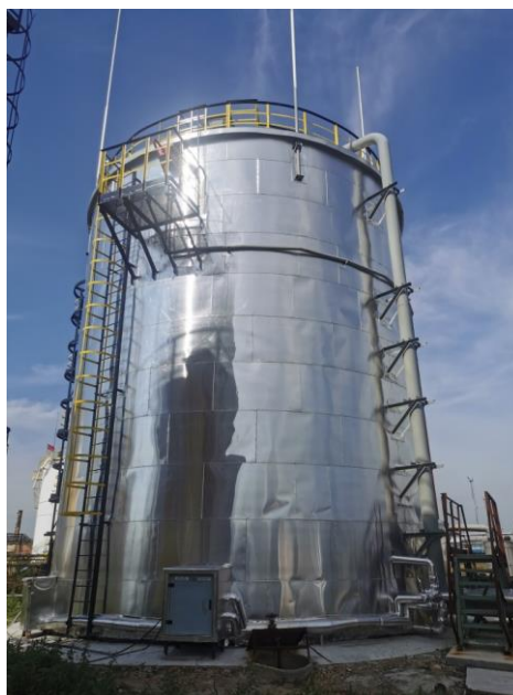
Рисунок 1 – Общий вид резервуара
