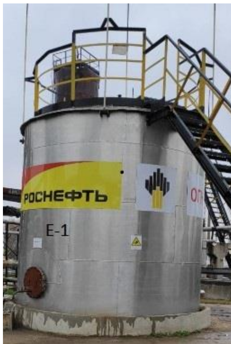
Рисунок 1 – Общий вид РВС-50 с заводским номером E-1
