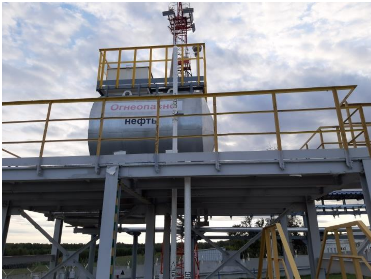
Рисунок 2 – Общий вид резервуара РГС-10
