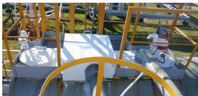
Рисунок 2 – Общий вид резервуаров РГС-20 зав.№№ 107, 108
