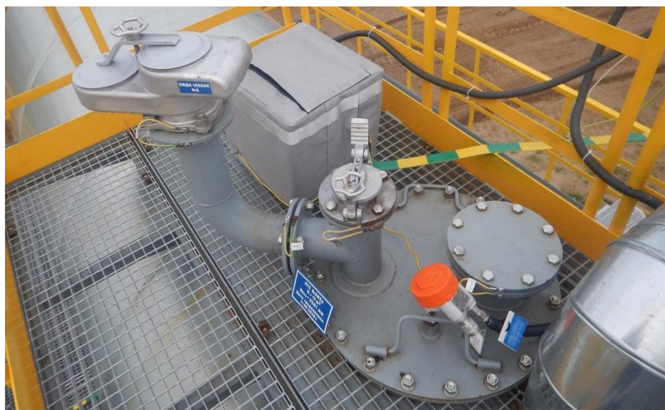
Рисунок 10 – Общий вид резервуаров РГС-20 зав.№№ 382, 383
