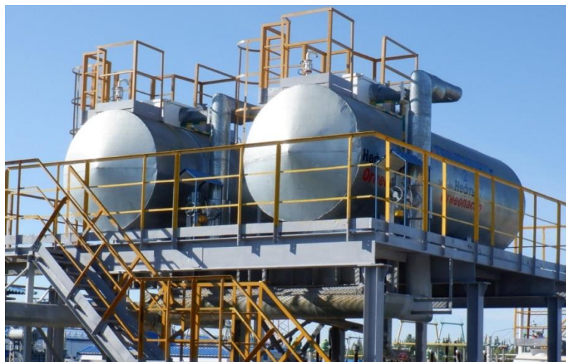
Рисунок 1 – Общий вид резервуаров РГС-20 зав.№№ 107, 108
