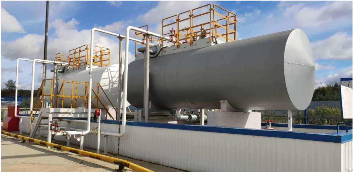
Рисунок 13 – Общий вид резервуаров РГС-20 зав.№№ 278, 279
