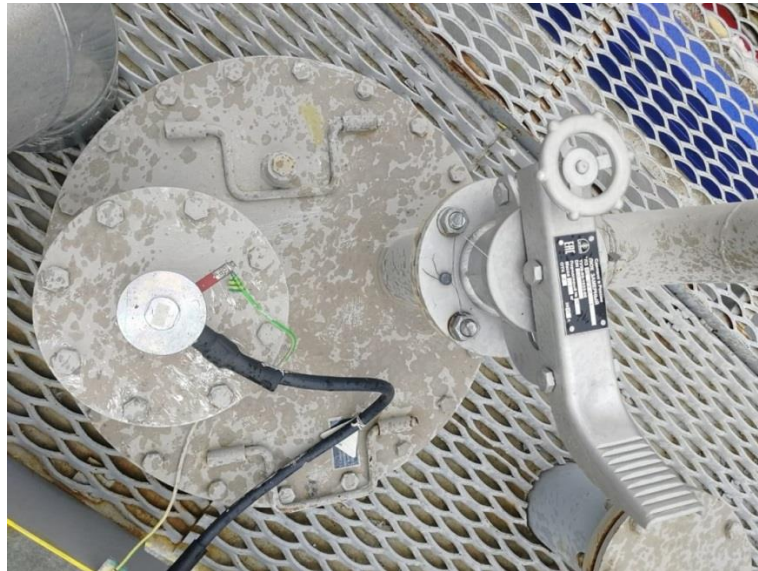
Рисунок 18 – Общий вид резервуара РГС-20 зав.№ 293
