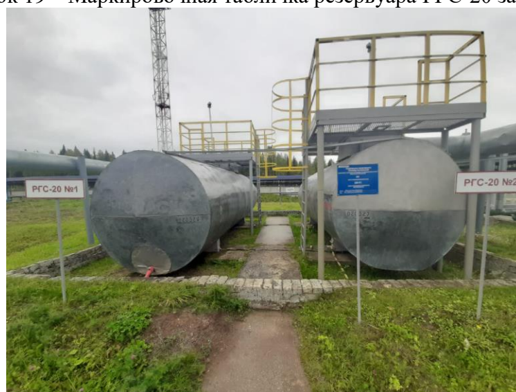
Рисунок 20 – Общий вид резервуаров РГС-20 зав.№№ 710, 711
