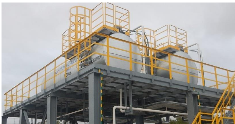
Рисунок 9 – Общий вид резервуаров РГС-20 зав.№№ 382, 383
