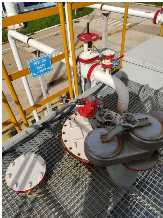
Рисунок 14 – Общий вид резервуаров РГС-20 зав.№№ 278, 279
