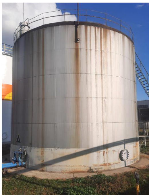
Рисунок 1 – Общий вид резервуара РВСП-700
