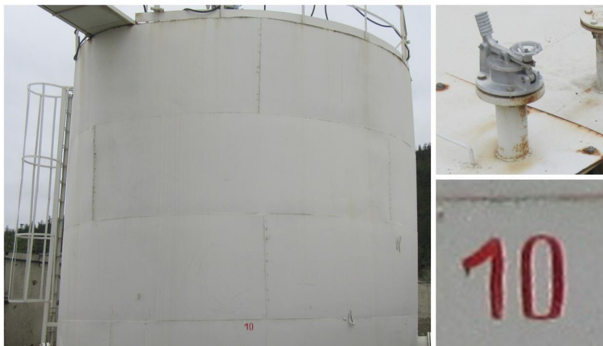
Рисунок 2 – Общий вид резервуара РВС-200 с заводским номером 10
