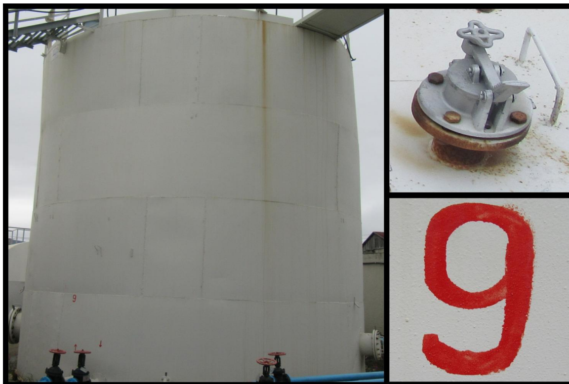
Рисунок 1 – Общий вид резервуара РВС-200 с заводским номером 9
