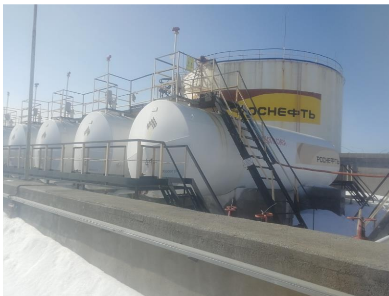
Рисунок 1 – Общий вид резервуаров РГС-65
