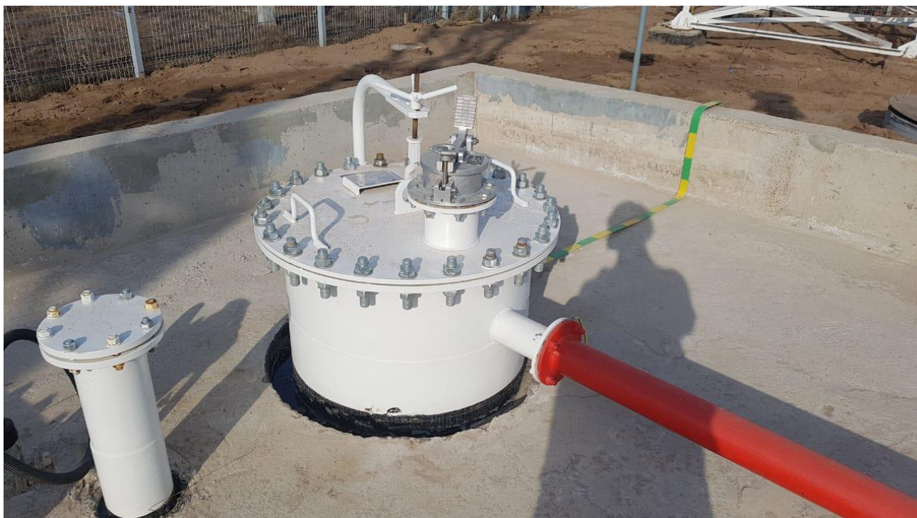
Рисунок 4 – Общий вид резервуара РГС-25
