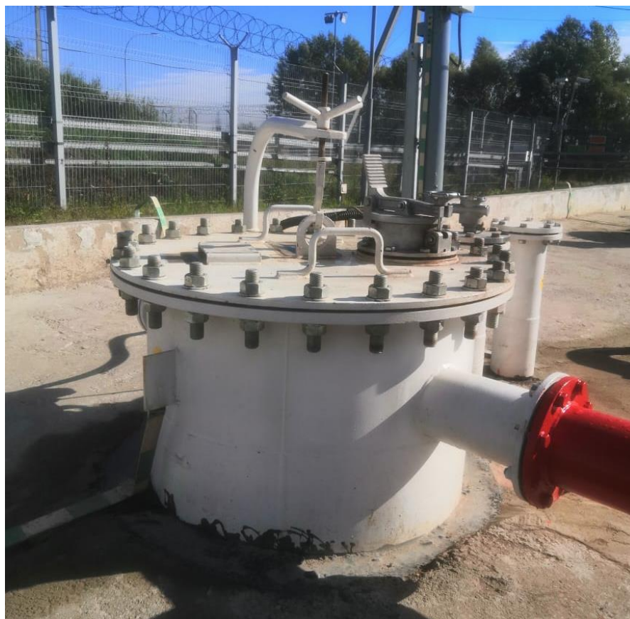
Рисунок 2 – Общий вид резервуара РГС-8
