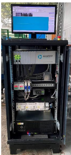
Рисунок 1 – Общий вид шкафа приборного системы измерения и управления стендом
