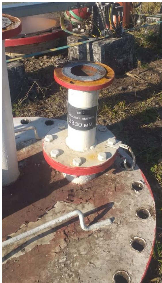
Рисунок 1 – Общий вид резервуара РГС-40
