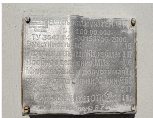
Рисунок 2 – Место установки и вид маркировочной таблички резервуара горизонтального стального цилиндрического РГС-16 зав.№ 10065
