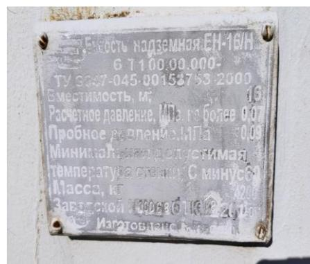
Рисунок 3 – Место установки и вид маркировочной таблички резервуара горизонтального стального цилиндрического РГС-16 зав.№ 10068
