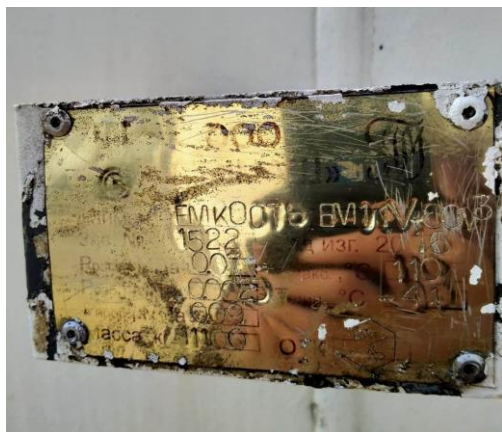
Рисунок 2 – Место установки и вид маркировочной таблички резервуара горизонтального стального цилиндрического РГС-75 зав.№ 1522
