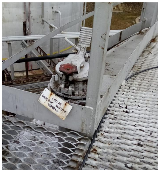
Рисунок 2 – Горловина и замерной люк резервуара стального горизонтального цилиндрического РВС-5000, заводской № 28
