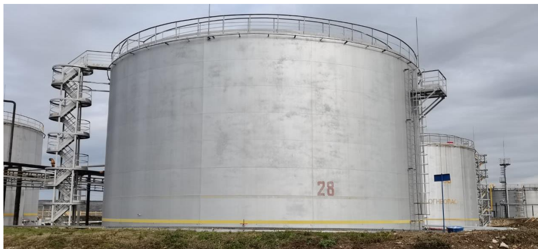
Рисунок 1 – Общий вид резервуара стального вертикального цилиндрического РВС-5000, заводской № 28
