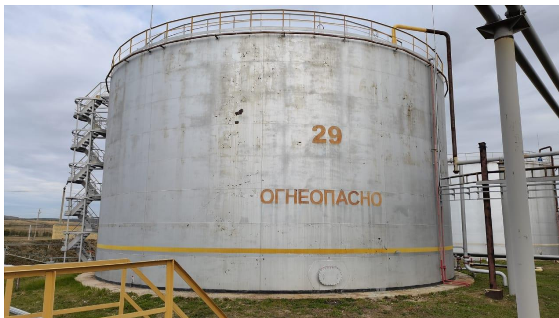
Рисунок 3 – Общий вид резервуара стального вертикального цилиндрического РВС-5000, заводской № 29
