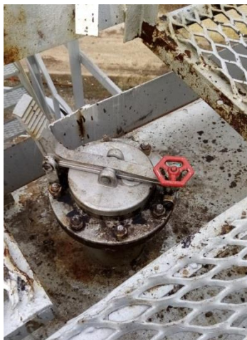
Рисунок 4 – Горловина и замерной люк резервуара стального горизонтального цилиндрического РВС-5000, заводской № 29
