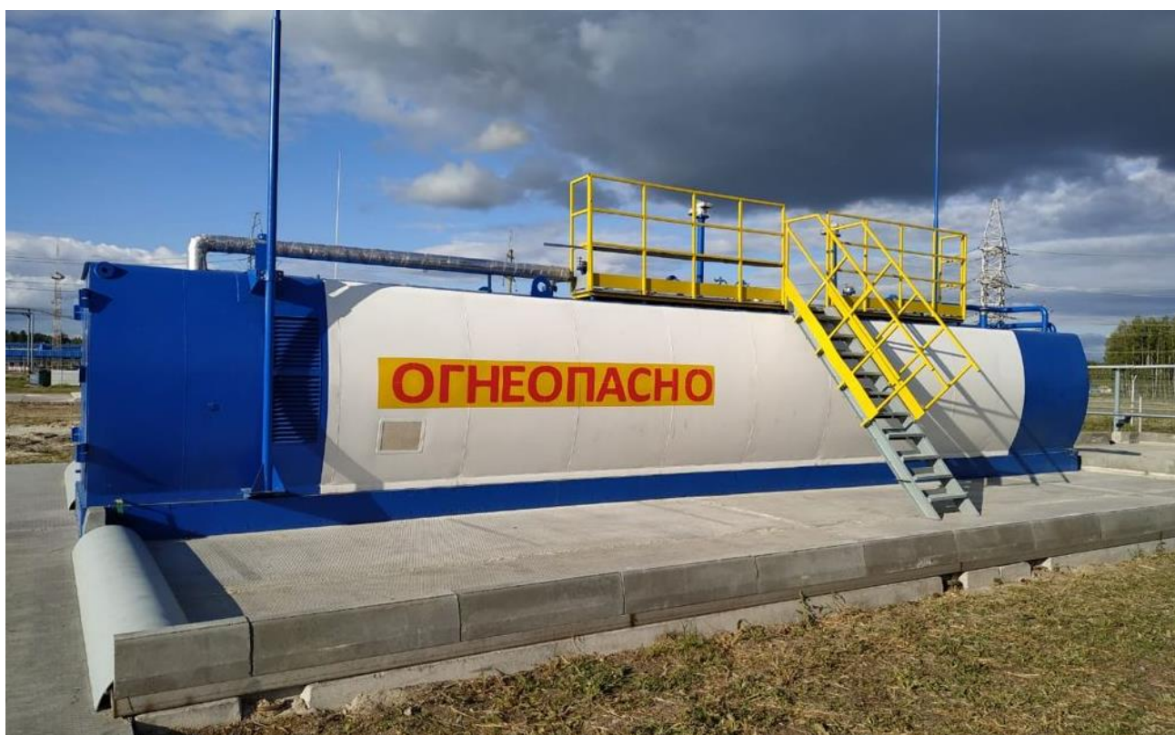
Рисунок 3 – Общий вид резервуара РГС-30
