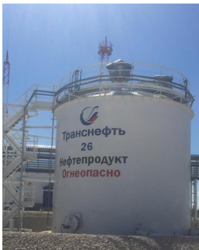
Рисунок 2 – Общий вид резервуара РВС-400 зав. № 26
