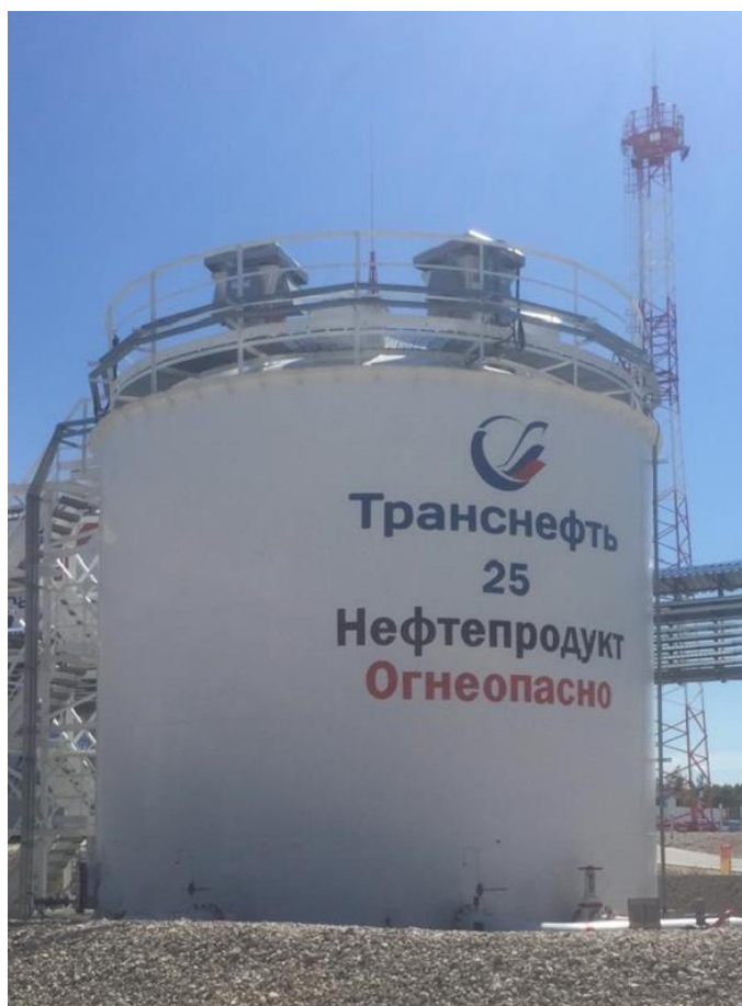
Рисунок 1 – Общий вид резервуара РВС-400 зав. № 25
