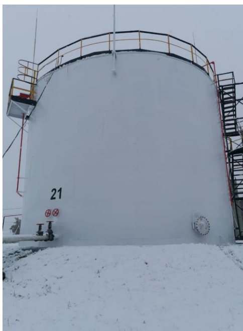
Рисунок 1 – Общий вид резервуара
