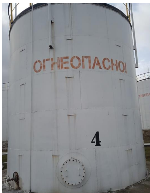
Рисунок 1 – Общий вид резервуара
