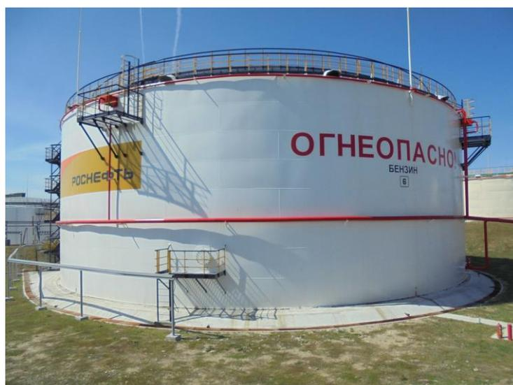
Рисунок 3 – Общий вид резервуаров РВСП-10000
