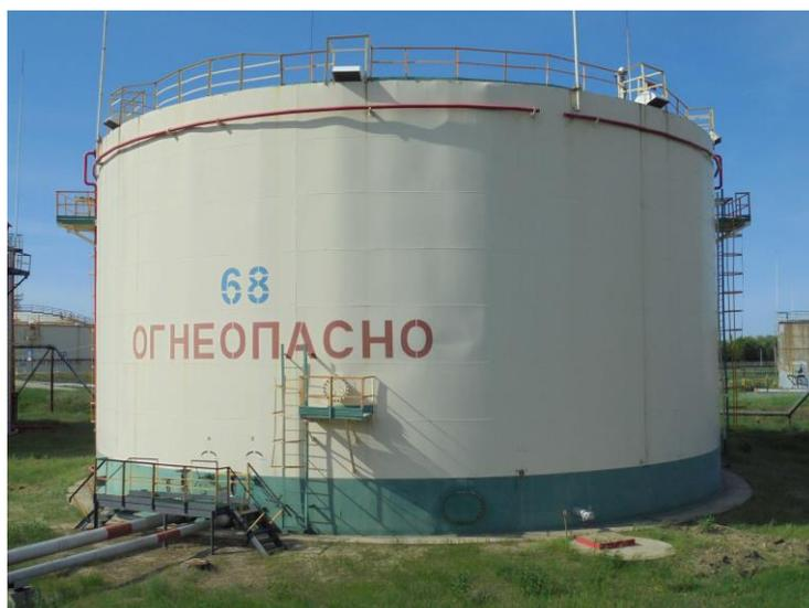
Рисунок 2 – Общий вид резервуаров РВСП-5000
