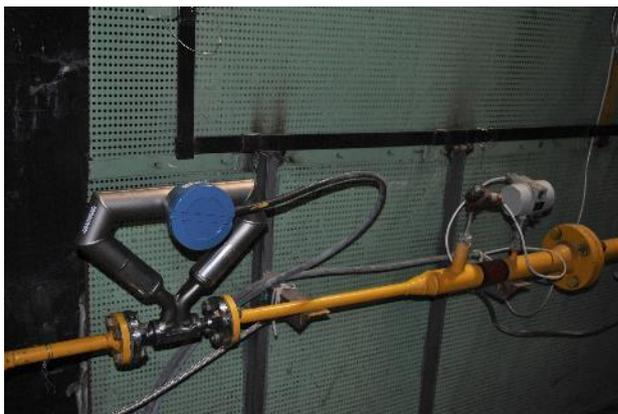
Рисунок 5 – Общий вид счетчика-расходомера массового Micro Motion CMF-50
