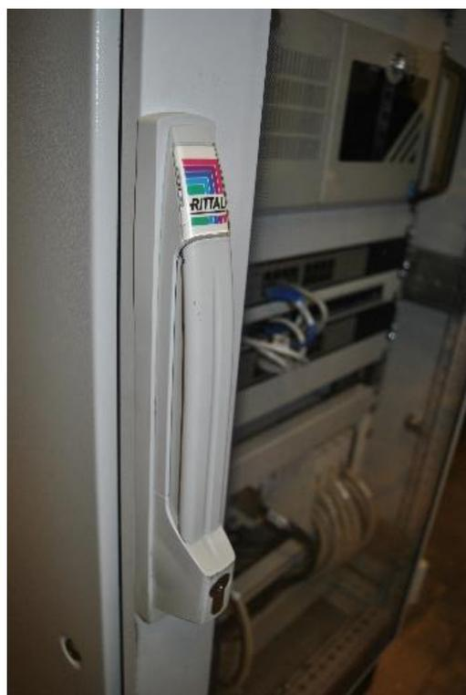
Рисунок 2 – Замок шкафа приборного
