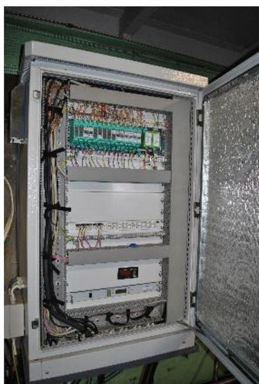
Рисунок 3 – Шкаф температурных преобразователей
