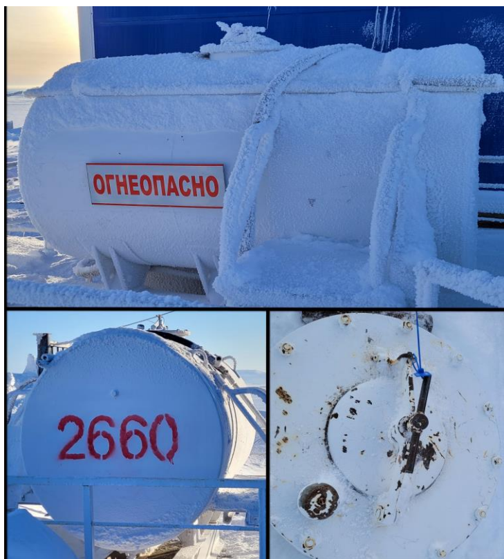
Рисунок 1 - Общий вид резервуара РГС-3 №2660
