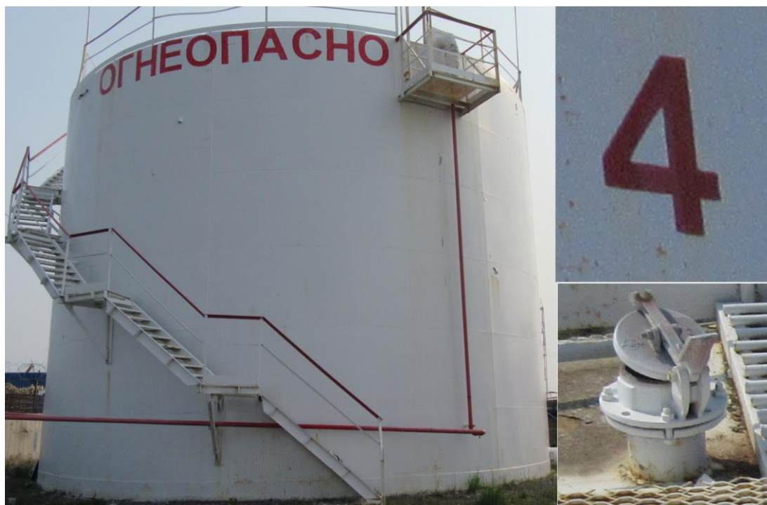
Рисунок 1. Общий вид резервуара РВС-1000 №4
