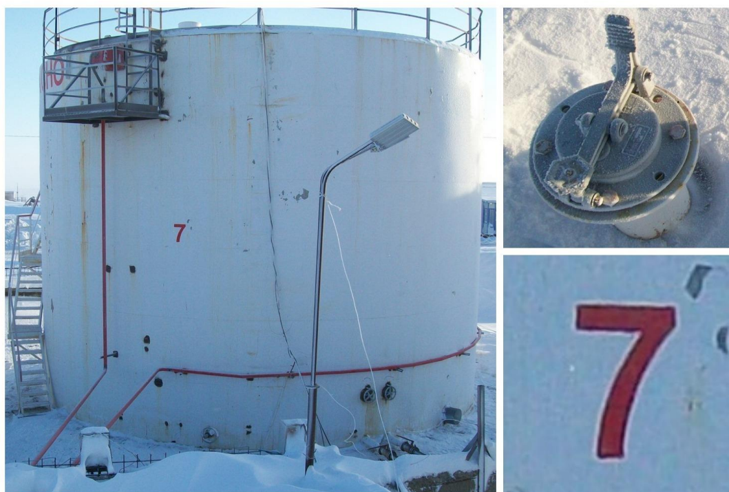
Рисунок 2. Общий вид резервуара РВС-1000 № 7
