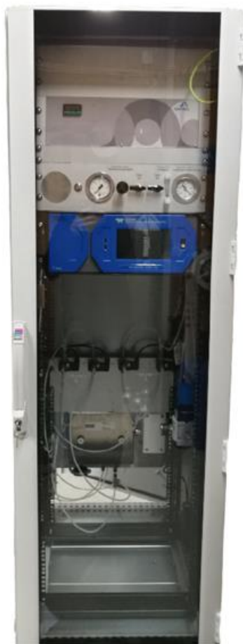
Рисунок 1 – Общий вид системы газового анализа CEMS-DIL-TR3
