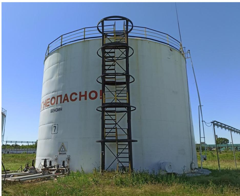
Рисунок 1 – Общий вид резервуара стального вертикального цилиндрического РВС-2000, Зав. №7
