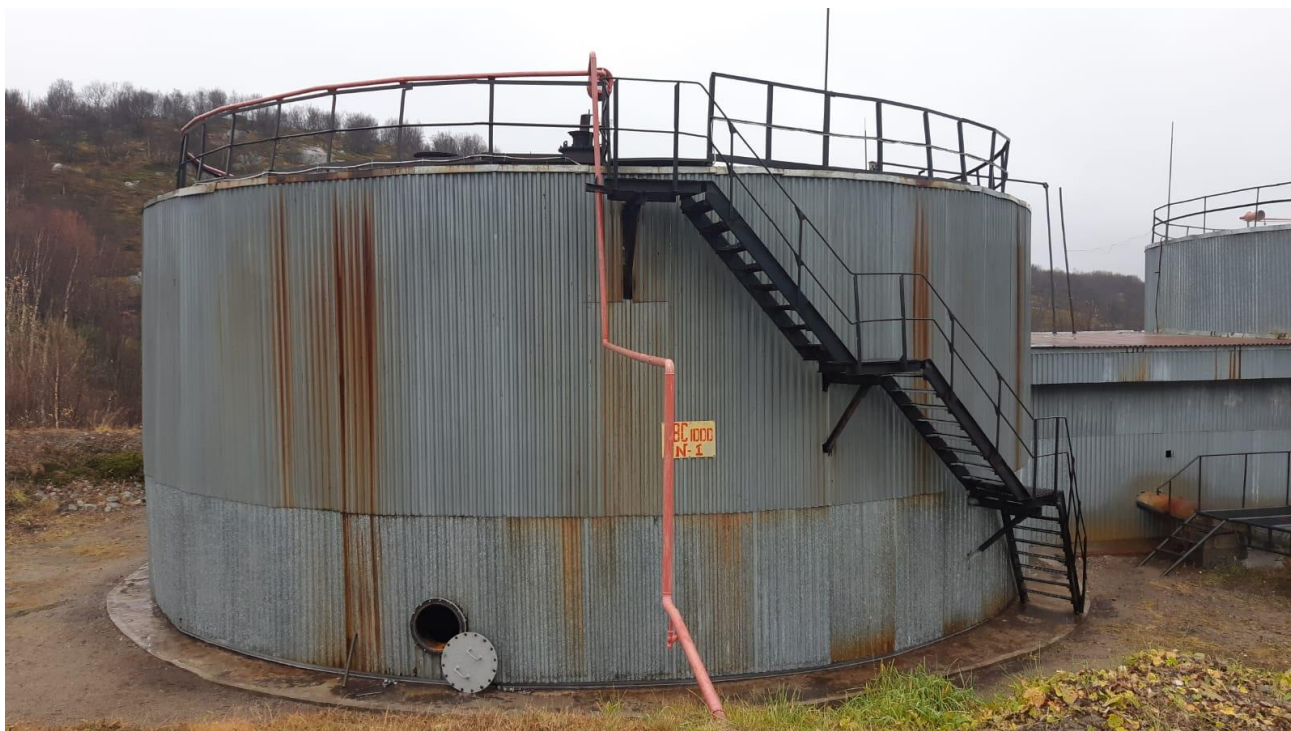
Рисунок 1 – Общий вид резервуара РВС-1000
