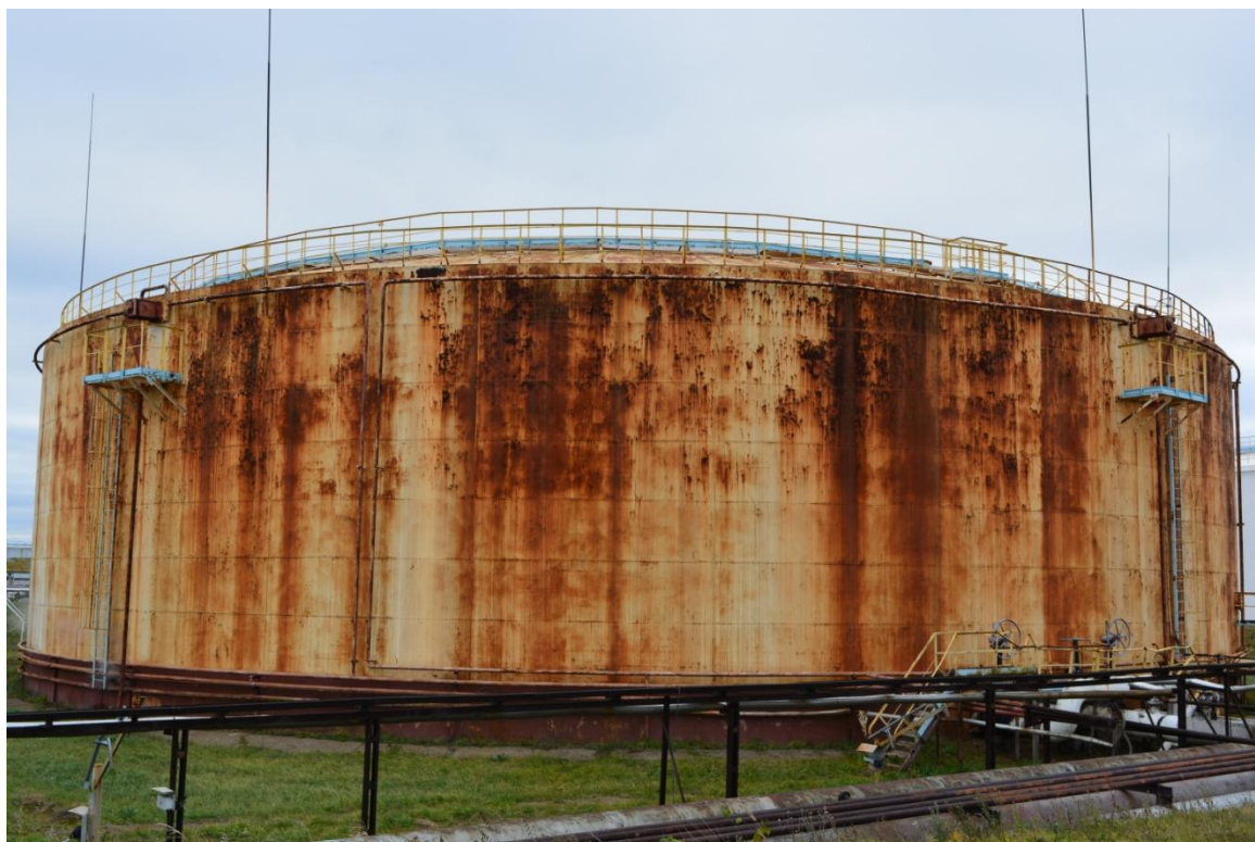
Рисунок 6 - Общий вид резервуара РВСП-20000 № 306
