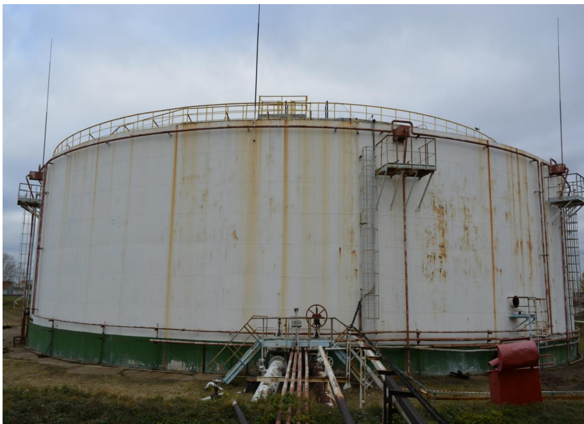
Рисунок 4 - Общий вид резервуара РВСП-20000 № 304
