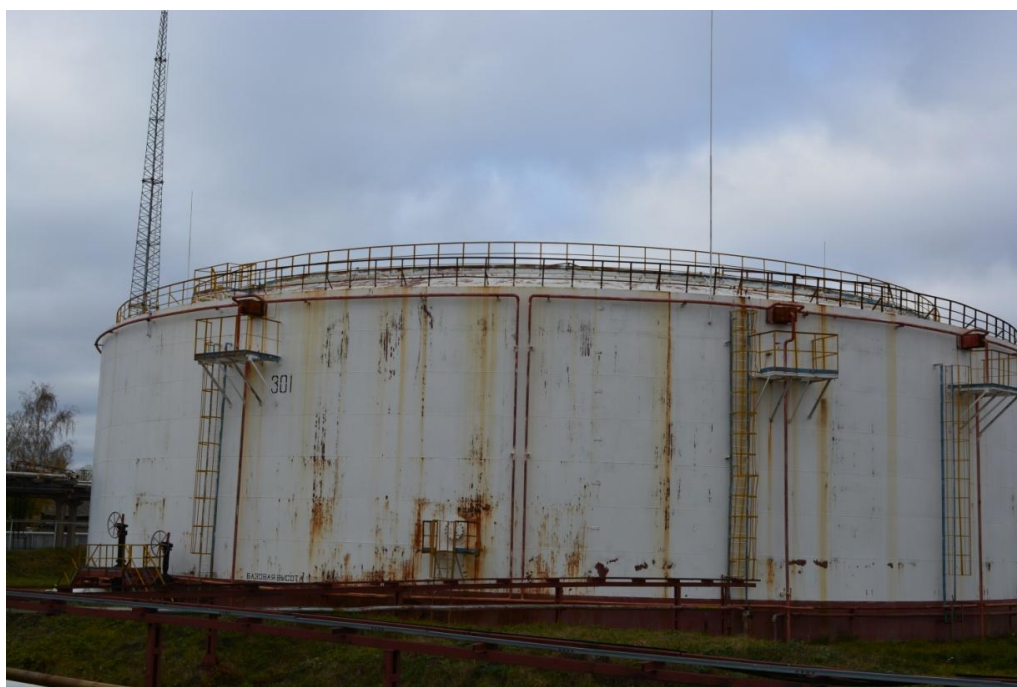
Рисунок 1 - Общий вид резервуара РВСП-20000 № 301
