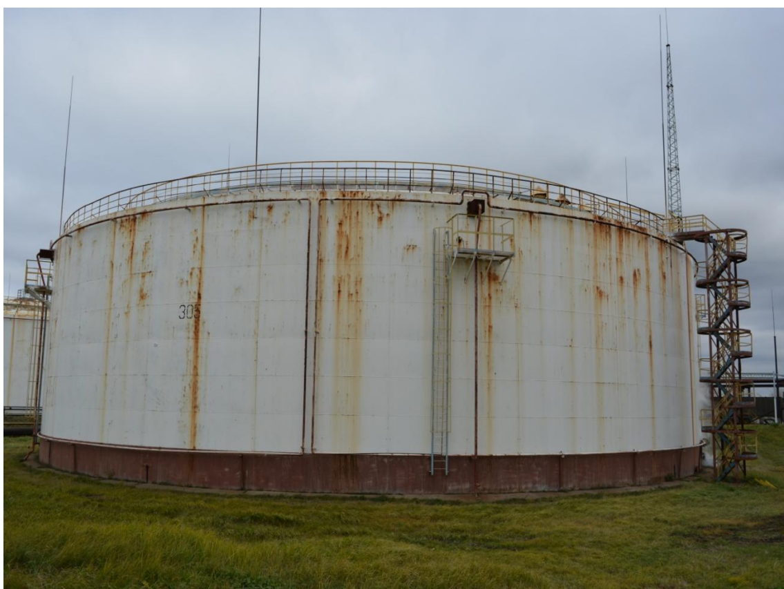
Рисунок 5 - Общий вид резервуара РВСП-20000 № 305
