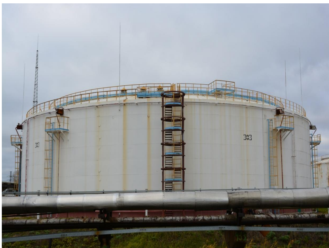
Рисунок 3 - Общий вид резервуара РВСП-20000 № 303
