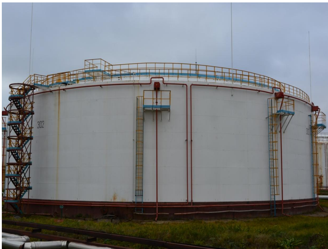
Рисунок 2 - Общий вид резервуара РВСП-20000 № 302
