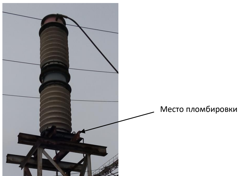
Рисунок 1 – Общий вид трансформаторов напряжения и схема пломбировки от несанкционированного доступа.
