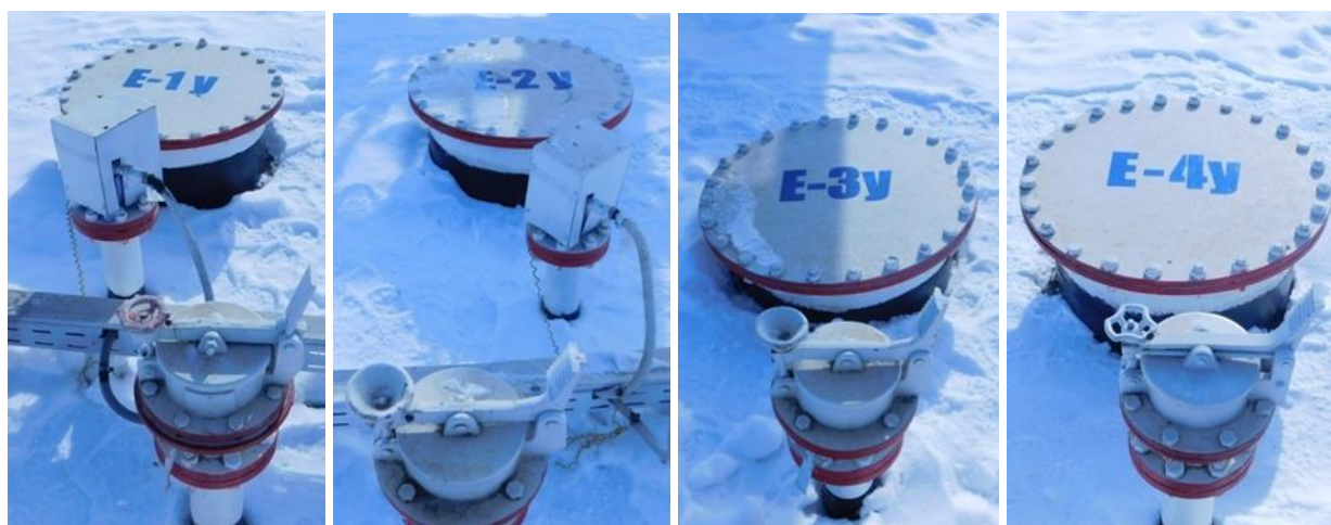
Рисунок 3 – Фотографии горловин резервуаров РГС-100 зав. №№ Е-1/100/Д, Е-2/100/Д, Е-3/100/Д, Е-4/100/Д
