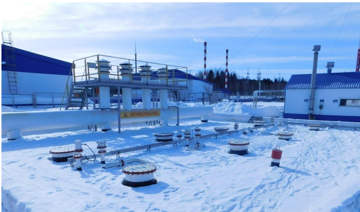
Рисунок 1– Общий вид площадки размещения резервуаров горизонтальных стальных цилиндрических РГС-100
