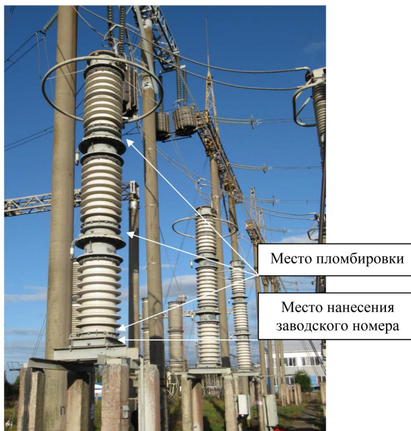
Рисунок 1. Общий вид средства измерений с указанием места пломбировки, места нанесения заводского номера
