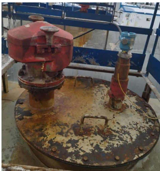
Рисунок 3 – Фото горловины резервуаров РГСН-100
