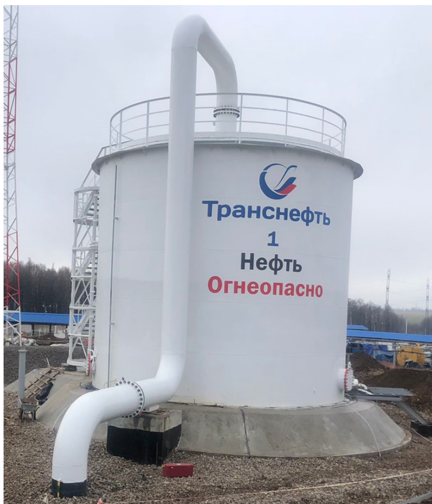
Рисунок 1 – Общий вид резервуара РВС-400
