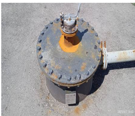
Рисунок 13 – Заводской номер, горловина и замерный люк резервуара горизонтального стального РГСп-100 заводской номер 19
