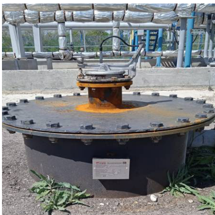
Рисунок 11 – Заводской номер, горловина и замерный люк резервуара горизонтального стального РГСп-100 заводской номер 18
